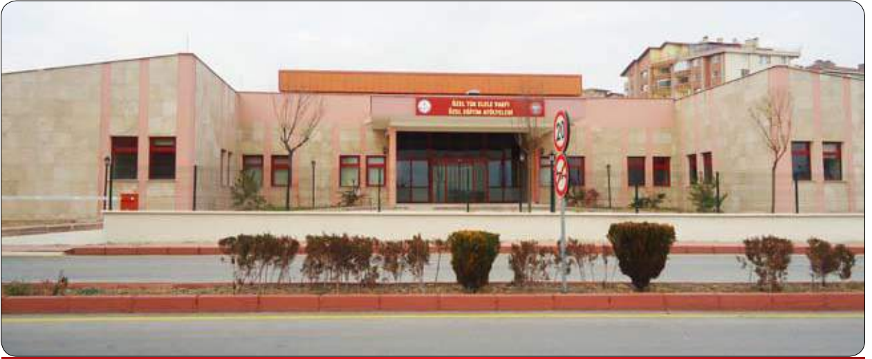
Mesleki Rehabilitasyon Merkezi / GATA İçi Etlik - ANKARA
